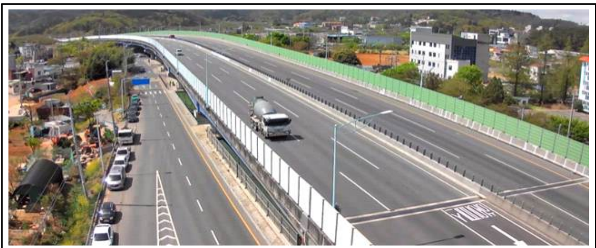
<그림 3.1> 연호고가교 측면 전경
