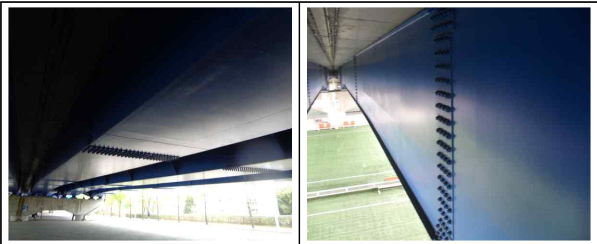
거더 외부 전경
