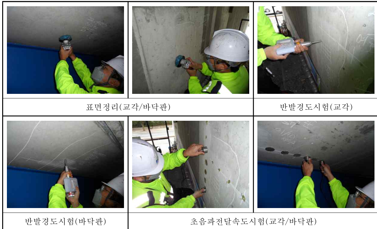
<그림 3.6> 콘크리트 강도조사
